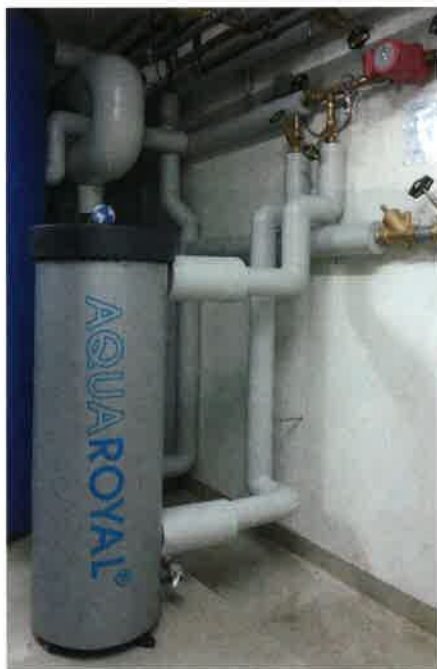
Bild 2 Korrosionsschutzanlage nach dem physikalischen Prinzip der Opferanodentechnik auf Magnesiumbasis
