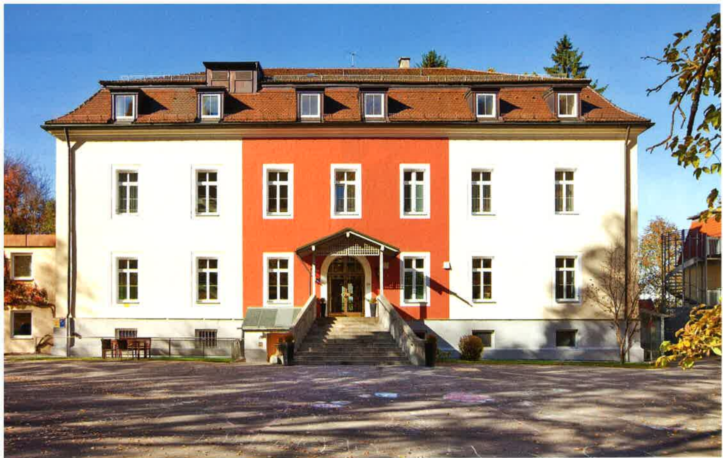
Im Karl-Eberth-Haus entschied man sich für den Einbau einer neuartigen Filteranlage in der Warmwasserzentrale.
