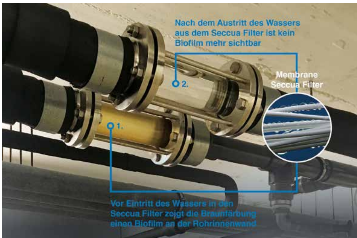
Biofilmbegrenzung durch Ultrafiltration am Hauswassereingang einer Klinik. Das Bild wurde nach ca. zwei Jahren Betrieb aufgenommen.
